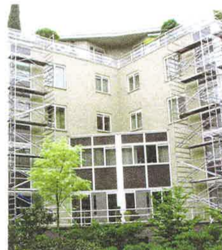
De aluminium steigers werden door het pand heen aangevoerd. Zo werd de tuin niet beschadigd en die van de buren niet betreden.
