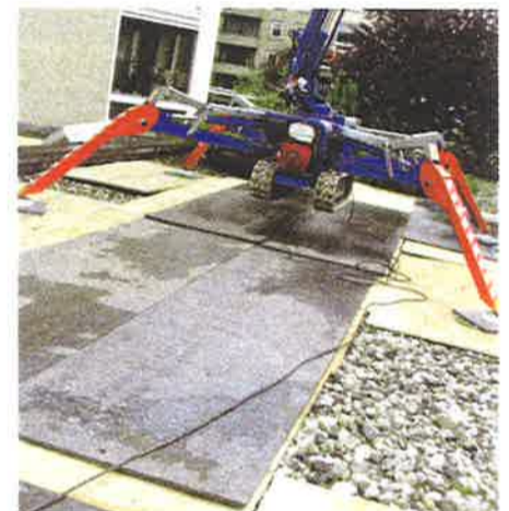
De hoogwerker wordt op het dak van de parkeergarage ingezet voor de efficiency. Voor voldoende drukverdeling worden rij- en underlaymentplaten dubbellaags toegepast.
