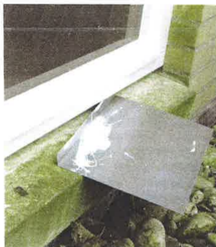
Typisch iets voor Mulder Schilders: om de onderkanten van de dorpels goed te kunnen schilderen beschikt het bedrijf over deze oorpeipiaatjes, die men zelf laat maken
