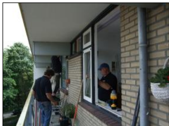
Tevens kunnen wij breukruiten vervangen en enkelglas vervangen door isolatieglas
